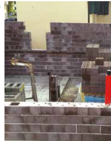
Muratura portante armata per le pareti perimetrali esterne e divisorie tra unità abitative in Lecablocco Bioclima Sismico.
